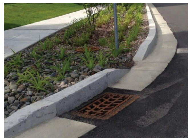
Noue de biorétention © RépertEAU, 2019
